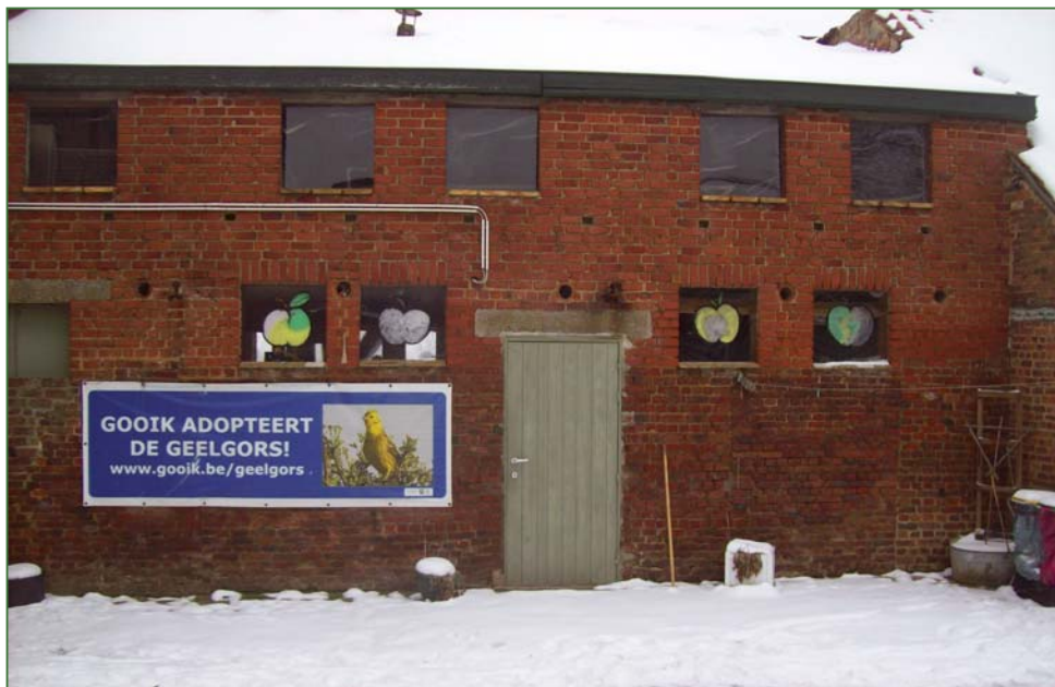
Verdoken achter het doek en ernaast: onderaan spoor van vensters en deur, en bovenaan van recente verbouwingen.
